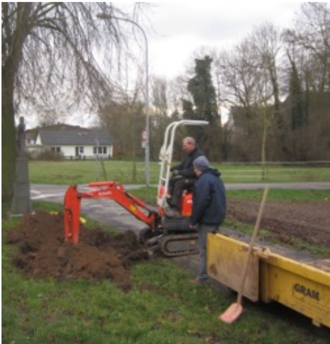
Vorarbeit mit Mobilbagger.
