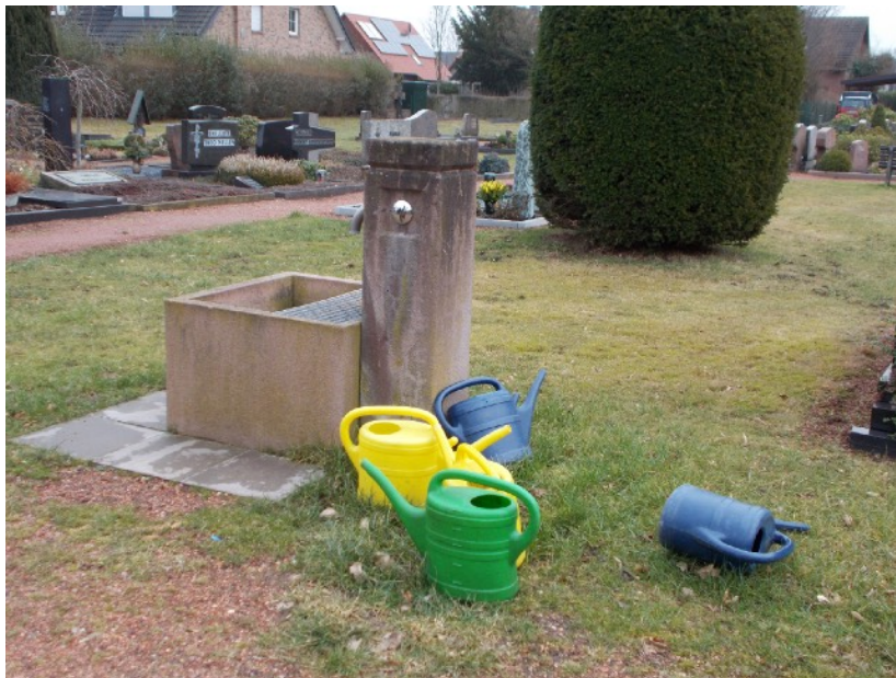
ZENTRALE WASSERZAPF- / -SCHÖPFSTELLE „FRIEDHOF JOSEF-LECHER-WEG“
