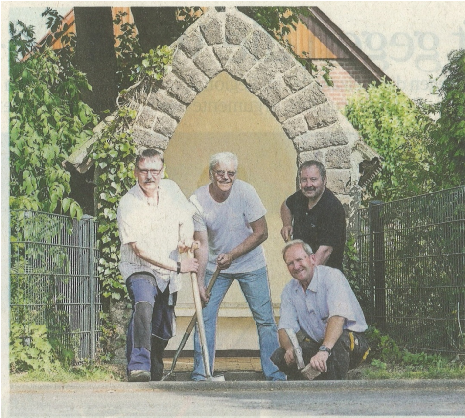
Unser abgeschlossenes Projekt „Sanierung historischen Flurkapelle“, Jahnstraße
