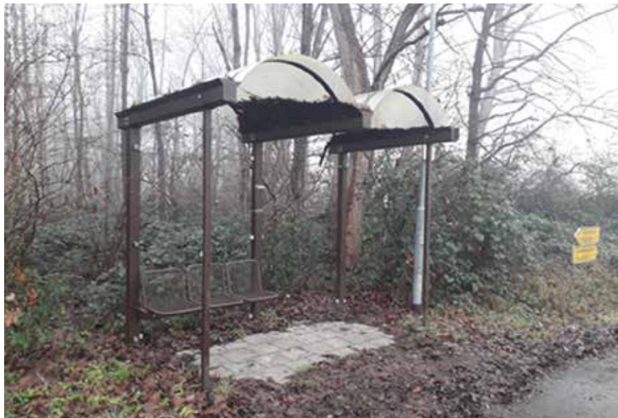
Buswartehalle K33 / Abzweig Münchrath (Januar 2021)
