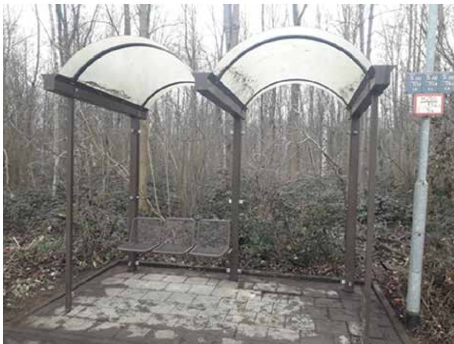
Gereinigte, ehemalige Buswartehalle (März 2021)
