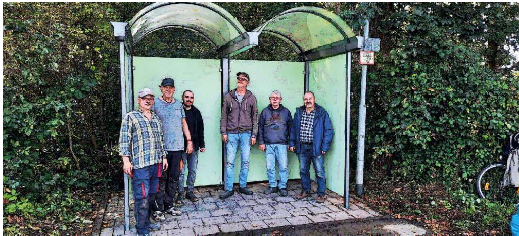
Neu montierte Seitenwände an der Wetterschutzhütte
