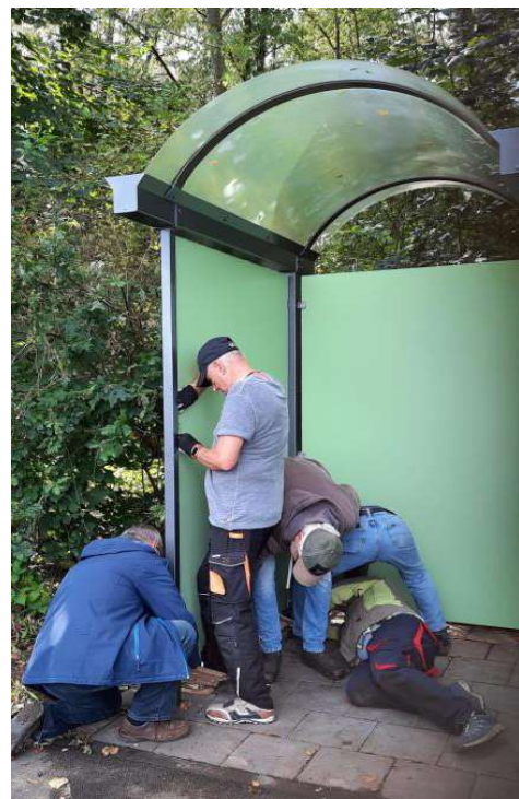
Montage letzte Platte mit vollem Einsatz
